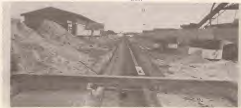
E sistema pa desagüe den construcion na Madiki.
